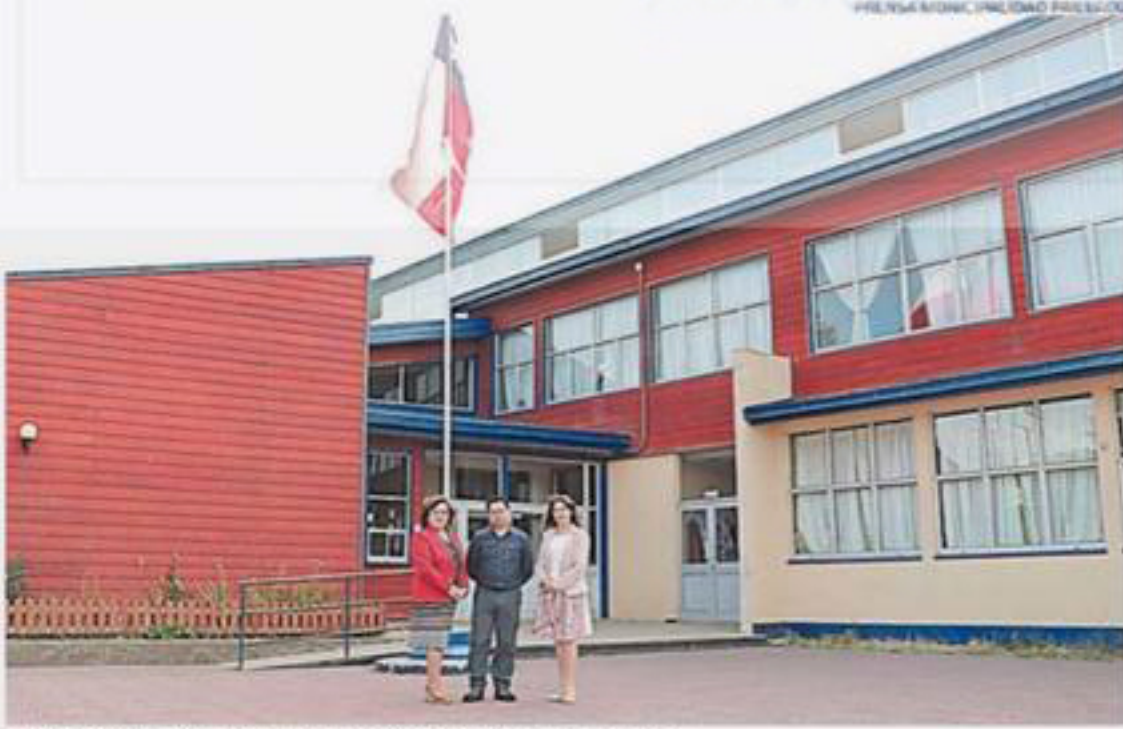
LOS TRABAJOS EN EL LICEO PAILLAQUINO ESTARÁN LISTOS EN JUNIO.
